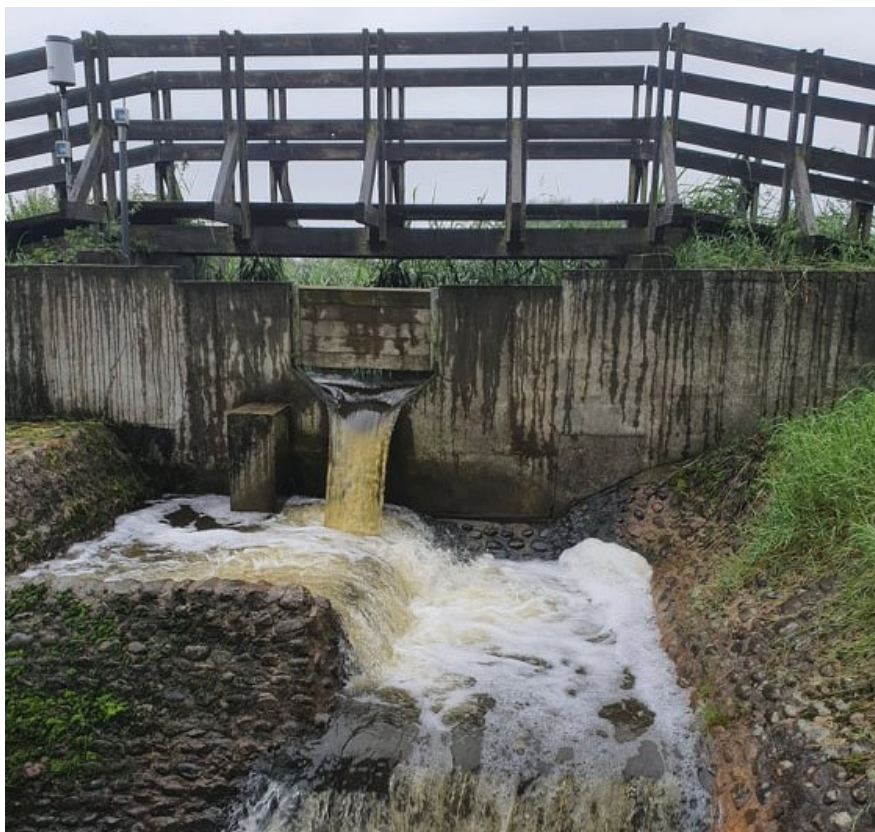
Figur 5-17 Foto af udløbsbygværket ved Tvebjerg Sø – dimensioner kan ses i Figur 5-16.
